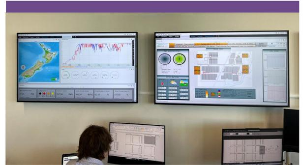
LodestoneのTakapunaオペレーションセンターは、Ovationエンタープライズデータソリューションサイトとシステムグラフィックを使用して太陽光発電所の運営を監視しています。
